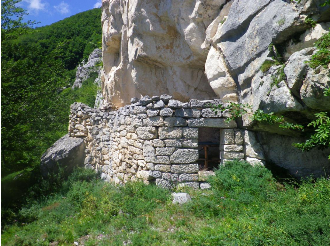
Ph. 2 Ruttë dë Angëmarinë: Esempio di grotta costruita con pietre lavorate e squadrate; forse originariamente un eremo (vd. sch. 99, p. 100).
